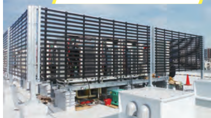
ビル屋上の目隠し 柵高=2.2m
