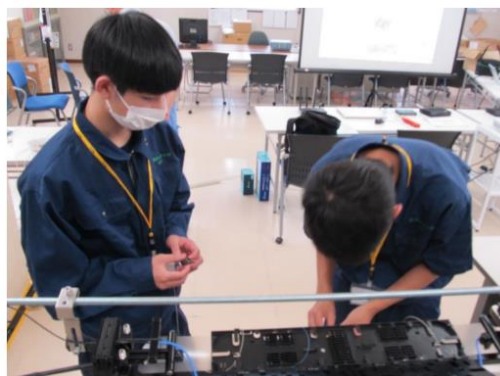
ケーブル接続作業
